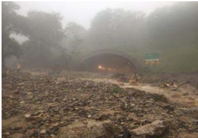
被災状況(道東道 狩勝第二トンネル)
