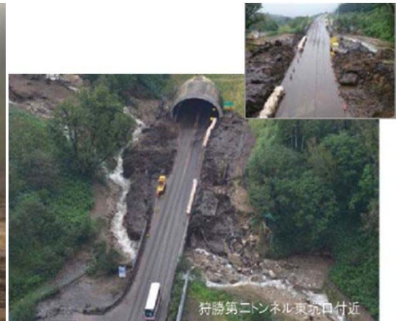
応急復旧による通行止め解除
